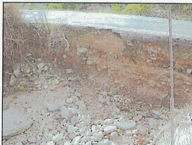
Foto 2 .- Vista de los materiales que aparecen en la zona de actuación.
