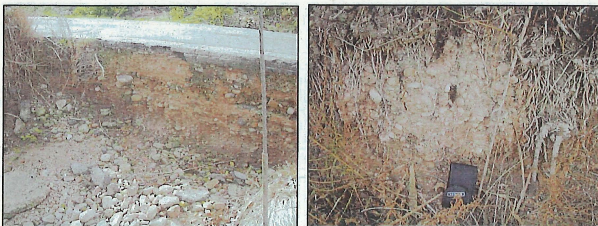
Fotografías nº 2 y nº 7 en las que se pueden observar las características de los materiales del terreno natural bajo la actual calzada.
